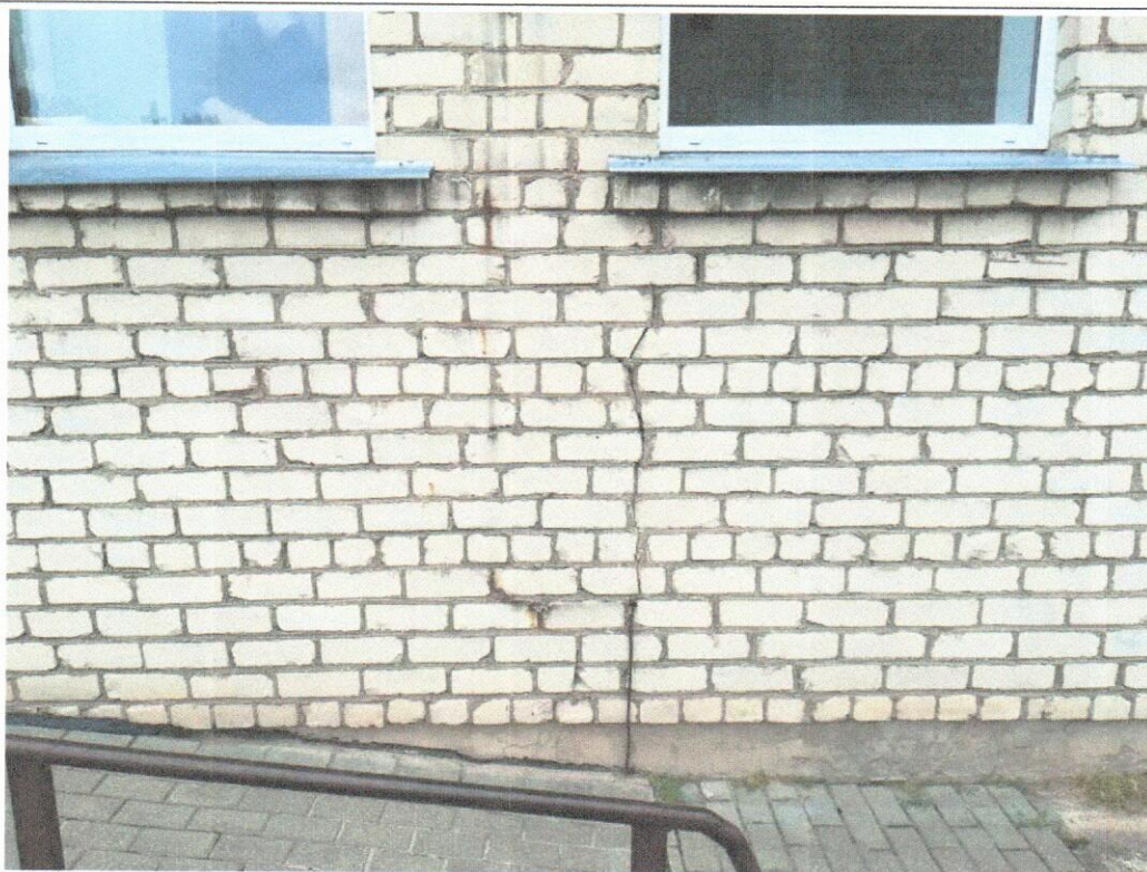
9.att. Vertikāla plaisa ēkas DA gala sienā, kas visdrīzāk izskaidrojama ar koncentrētu slodzi no nesošās ķieģeļu kolonnas iekštelpās (starp logiem).
