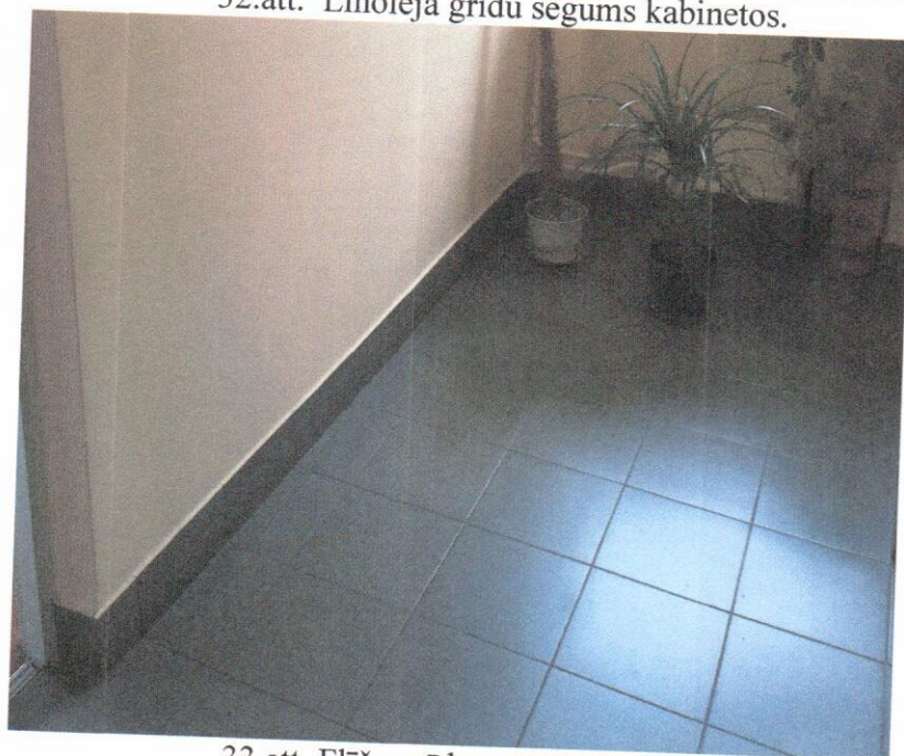
33.att. Flīžu grīdas segums gaitenā.
