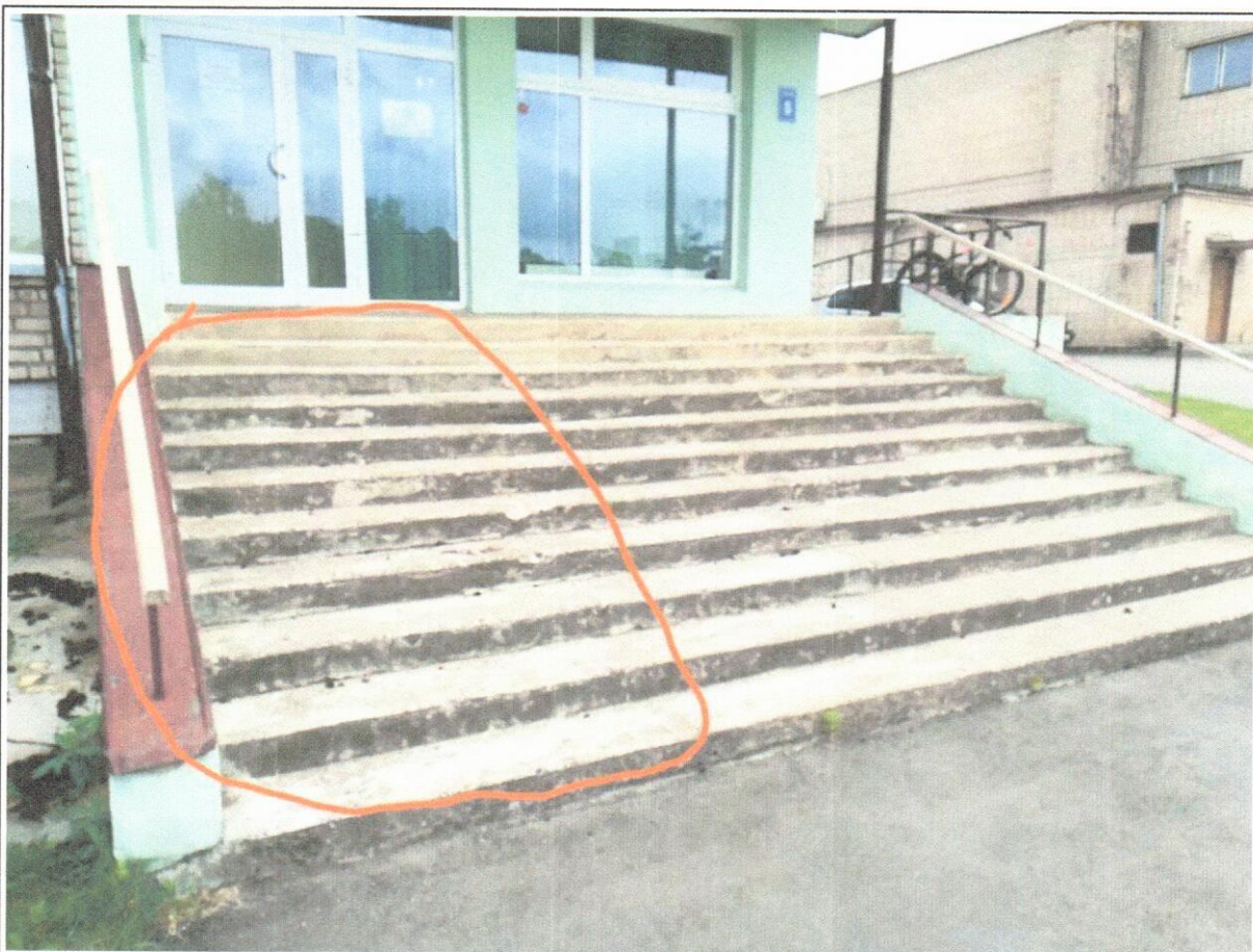
26.att. Kāpnes uz galveno ieeju ar piebetonētu papildus apjomu. Kāpnes daļēji apdrupušas un vizuāli nolietotojušās.
