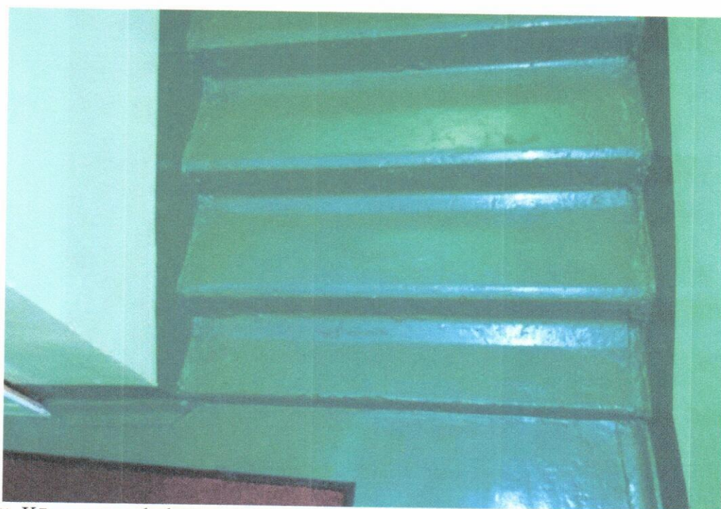
31.att. Kāpnes uz cokolstāvu. Pakāpieni nevienāda augstuma, kas liecina par būvniecības atkāpēm vai papildus betonētu grīdu.
