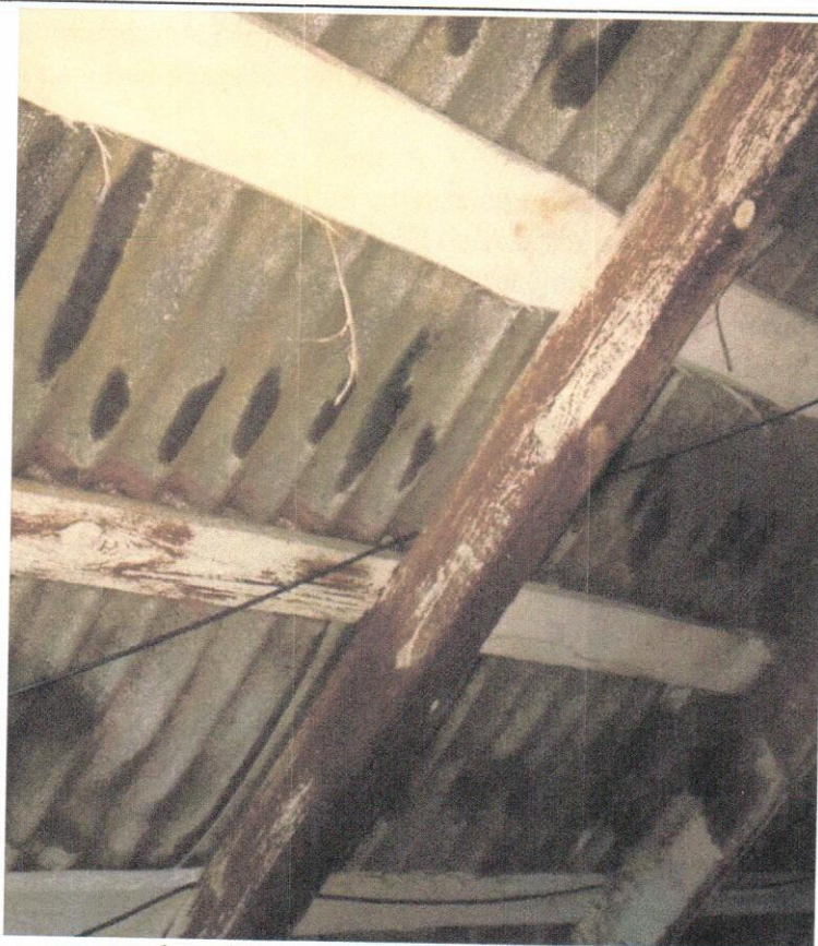
19.att. Jumta segumam redzami lietus caurtecējuma plankumi. Loksnes ir samitrinātas. Uz spārēm redzams darvojums.
