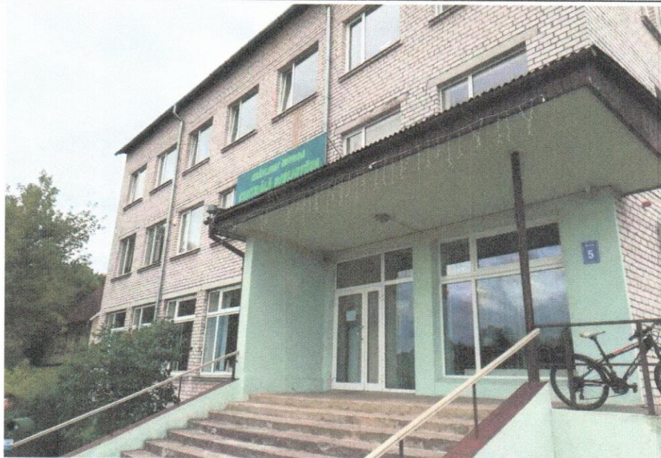
34.att. Pārbūvētais ieejas mezgls. Durvis iebūvētas loga vietā un izbūvēts, visdrīzāk, jauns jumtiņš.
