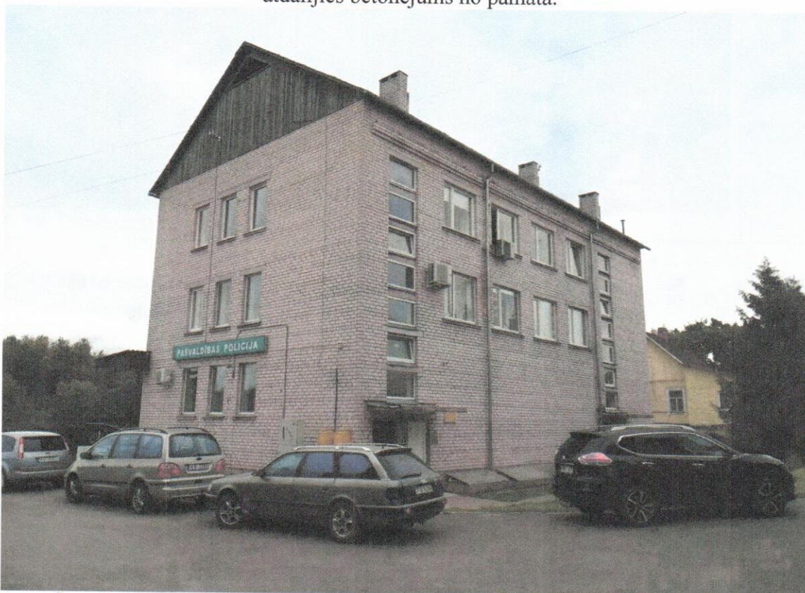
47. att. Ēkas kopskats no pagalma puses. Ēkas frontona apšuvums ar nekrāsotiem dēļiem, kas pazemina ēkas vizuālo stāvokli.
