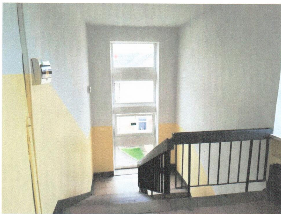
29.att. Kopskats uz ēkas kāpņutelpu 3. stāvā.
