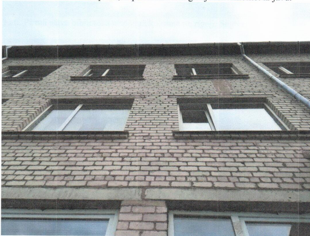
12.att. Ēkas galvenās fasādes logu aiļu pārsedzes.
