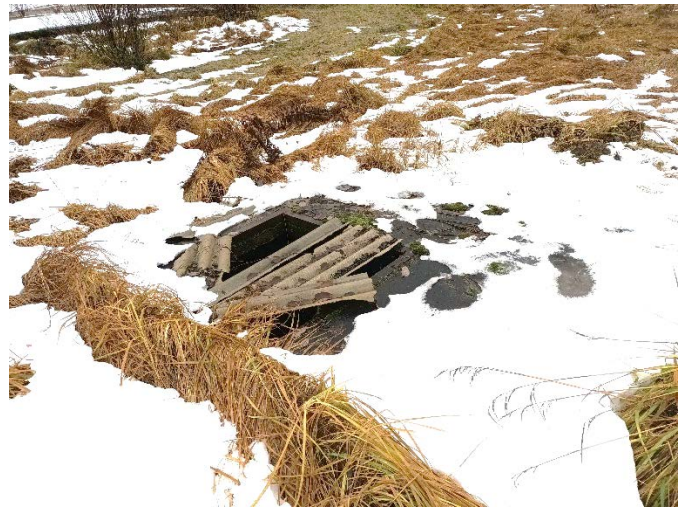
Inženierkomunikāciju/kanalizācijas aka
