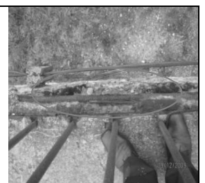
3.attēls. Gājēju pārejai bojāta horizontālā hidroizolācija, 4.attēls. Bojāti ūdensnotekas izvadi un tiek bojātas dzelzsbetona konstrukcijas.
