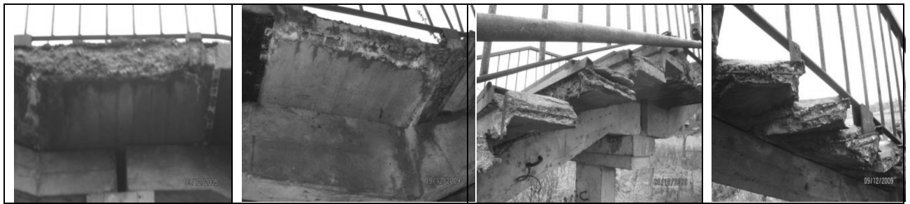
9.,10.,11.,12.attēli. Ūdens un sala ietekmē bojāti kāpņu laukumu un pakāpienu ārējās malas.
