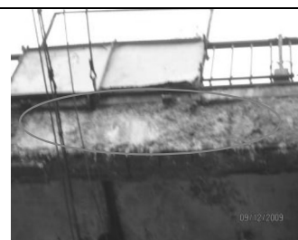
5.,6.,7.,8.attēli. Daudzās vietās bojāta stiebrojuma betona aizsargkārtā
