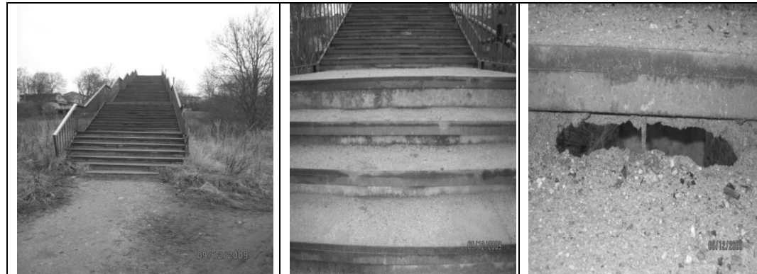
13.,14.,15.attēli. Vietām pakāpienu vertikālās daļas izdrupušas.
