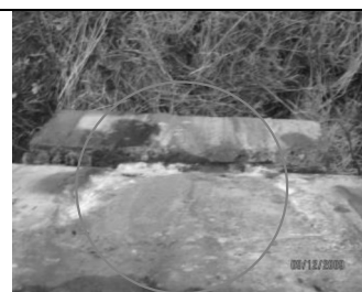
5.,6.,7.,8.attēli. Daudzās vietās bojāta stiebrojuma betona aizsargkārtā
