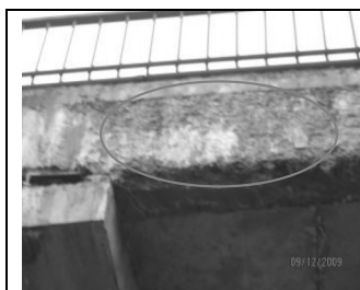
5.,6.,7.,8.attēli. Daudzās vietās bojāta stiebrojuma betona aizsargkārtā
