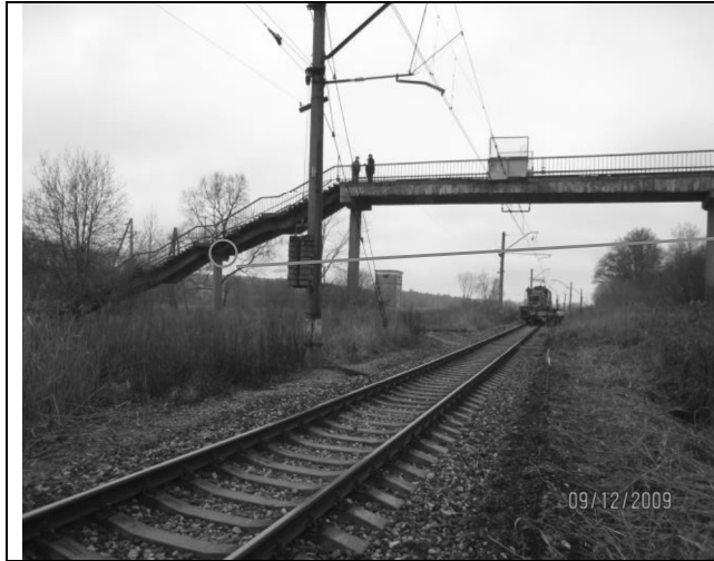
1.,2.attēls. Balsta vietā kāpņu laida rīgelim ūdens un sala ietekmē bojāta stiebrojuma betona aizsargkārtā.
