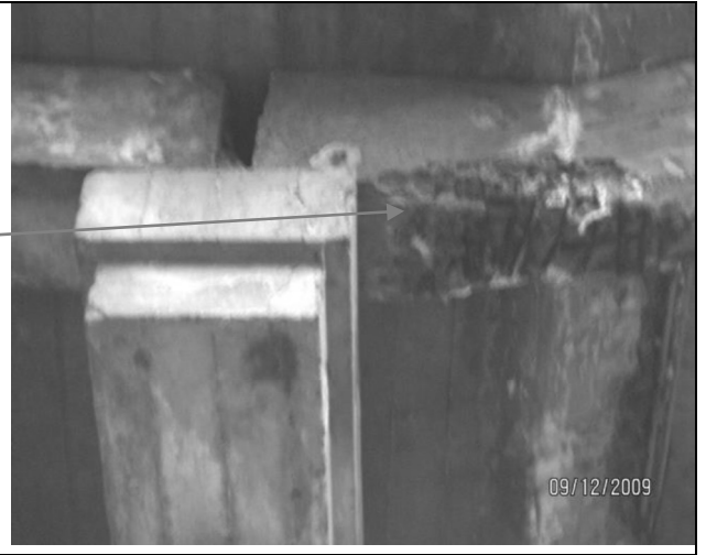
1.,2.attēls. Balsta vietā kāpņu laida rīgelim ūdens un sala ietekmē bojāta stiebrojuma betona aizsargkārtā.
