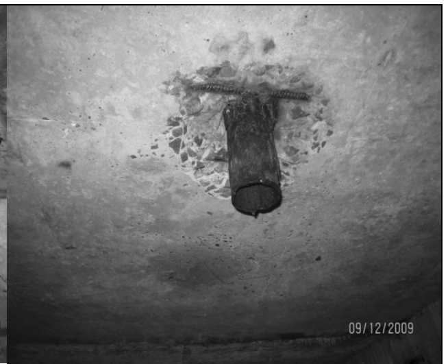
3.attēls. Gājēju pārejai bojāta horizontālā hidroizolācija, 4.attēls. Bojāti ūdensnotekas izvadi un tiek bojātas dzelzsbetona konstrukcijas.
