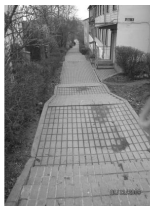
23.attēls. No pilsētas centra līdz gājēju pārejai izbūvēta ietve no betona bruģakmens.
