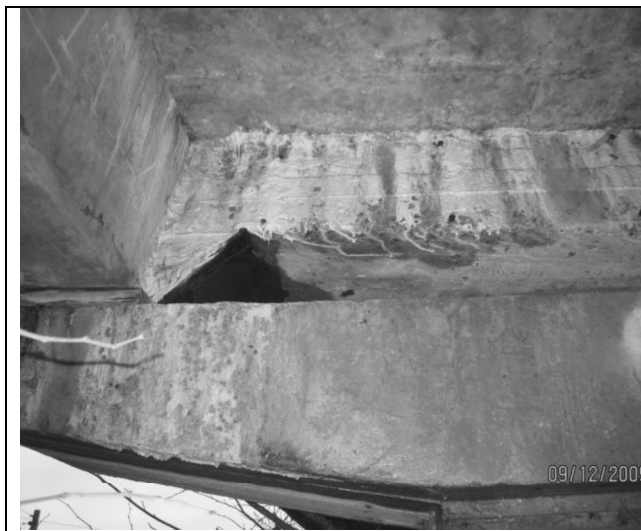
3.attēls. Gājēju pārejai bojāta horizontālā hidroizolācija, 4.attēls. Bojāti ūdensnotekas izvadi un tiek bojātas dzelzsbetona konstrukcijas.
