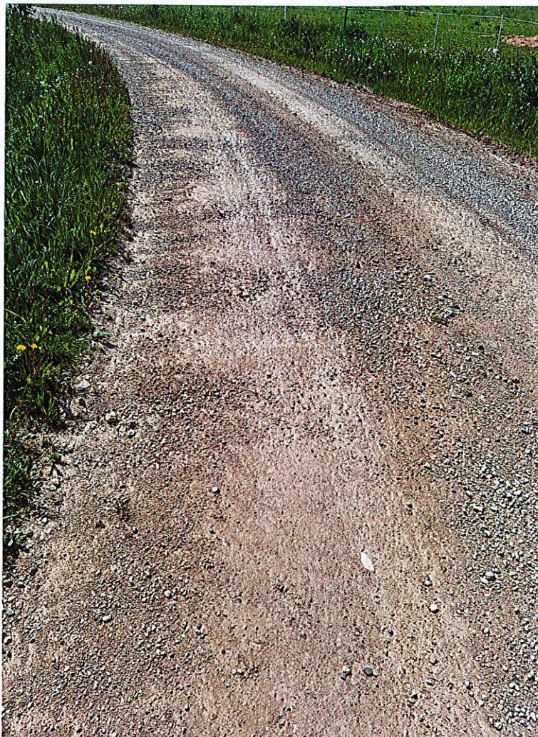
Attēls Nr.1 Jersikas pagasta autoceļa J13 maršruta "Āriņi - Dimanti" Ceļa izskalojumi
