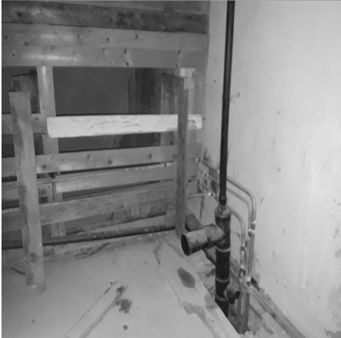
Ūdens un kanalizācijas sistēma izbūvēta, remonta stadijā.
